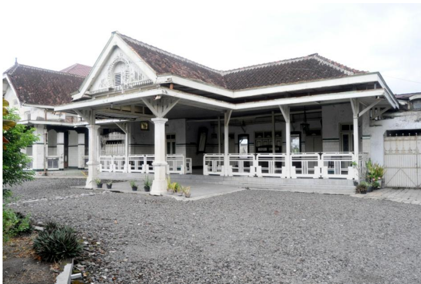
Tampak bangunan utama (pendopo & senthong tengah)
