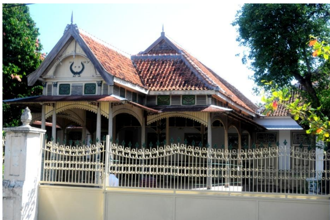
Tampak Muka bangunan utama ( pendopo ) limasan dengan kuncungan
